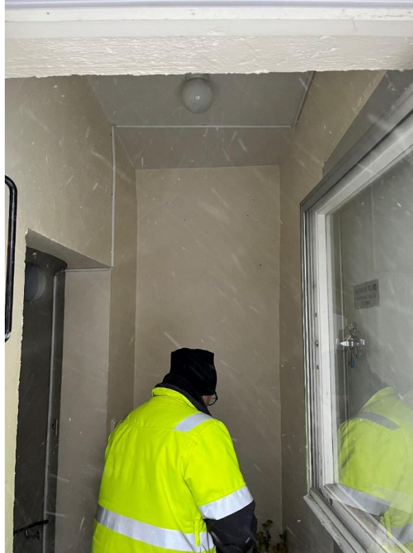
Figur 9 Ledig väggyta ovanpå trapphus
