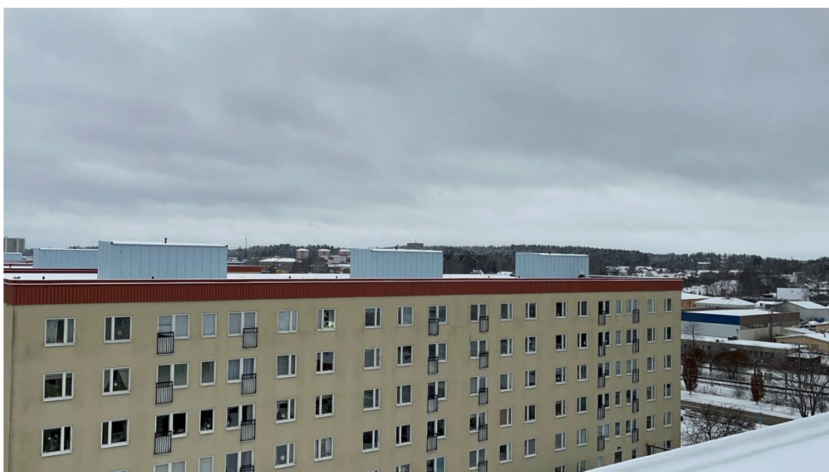
Figur 5 Tak på högre byggnader med hissmaskingrum
