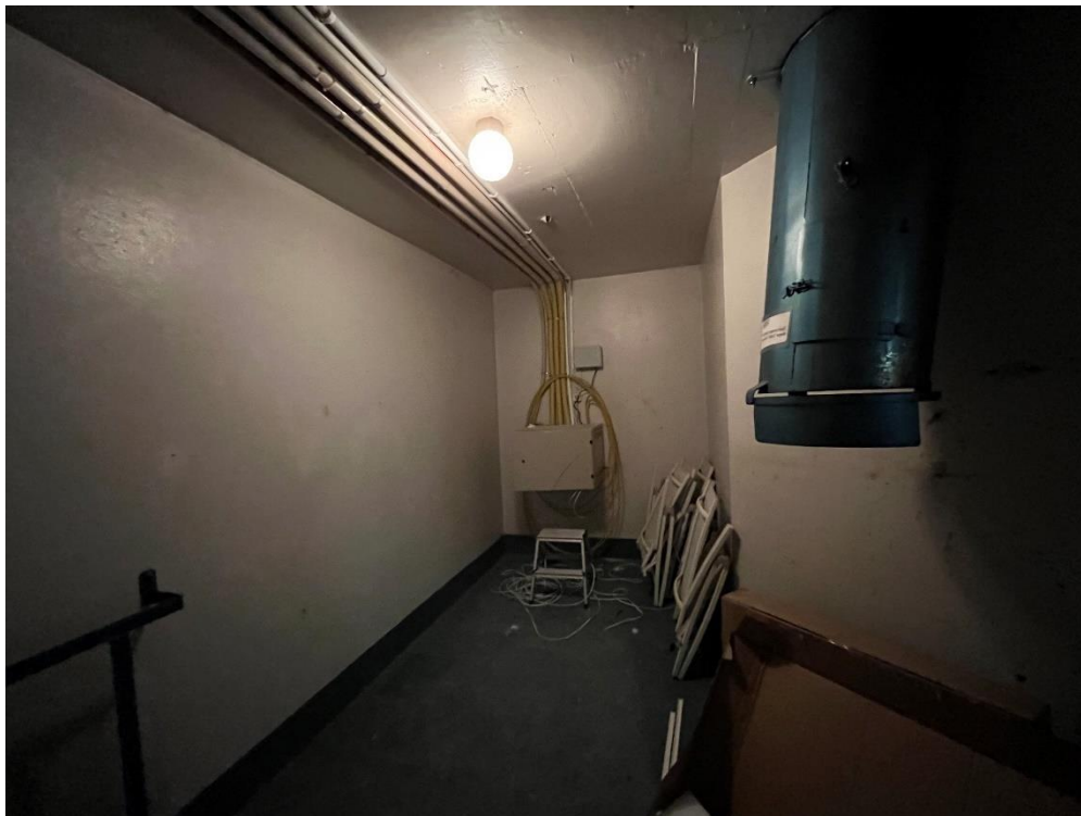
Figur 10 Oanvända soprum där växelriktare kan placeras
