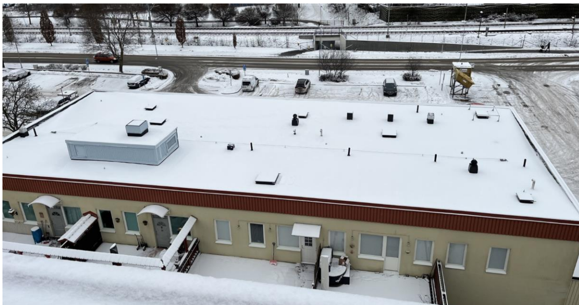
Figur 4 En av takytorna med lägre höjd i Viggbygården
