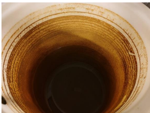
Figur 10 - Öppna expansionskärl med mycket avlagringar.
