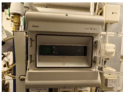
Figur 15. Schneiders SmartX Controller från 2019
