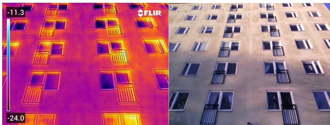
Figur 4 - Termografi och fotografi av ett höghus långsida
