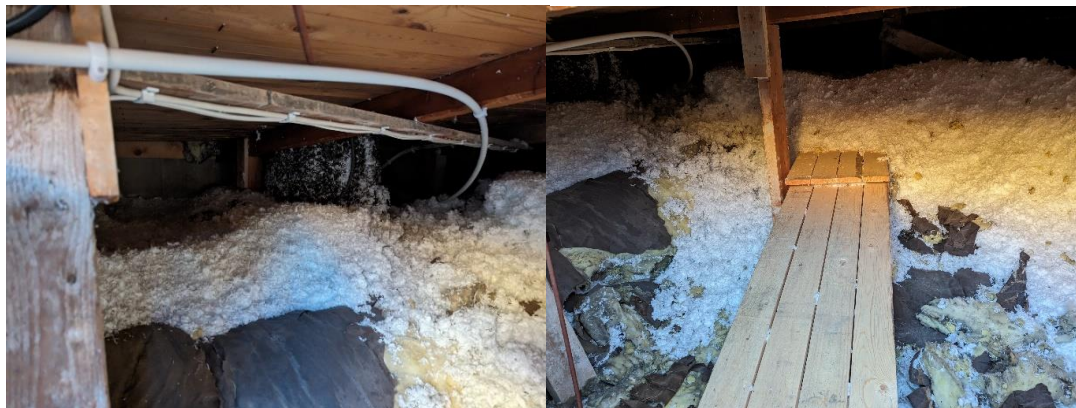
Figur 3 - Kallvind med tilläggsisolering
